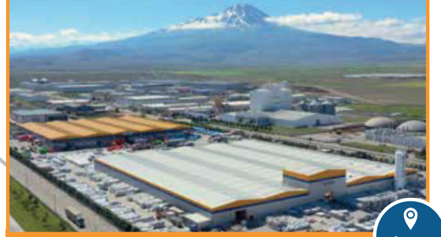
PVC-U ve PP-R Sistem Üretim Tesisi
