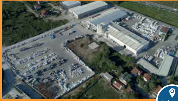
PVC-U Sistem Üretim Tesisi
